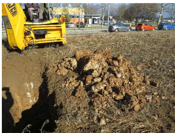
Slika 4: Tipična zemljina iz spodnjega dela odseka 1,7m - 3,8m izkopa I-2
